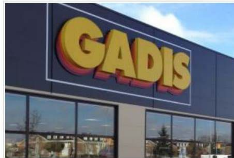
El nuevo supermercado se encuentra situado en la Avenida de Asturias, una ubicación con buena comunicación para dar servicio a los residentes de Santa Marta de Tormes y poblaciones limítrofes y ofrecer una alternativa a los clientes de Salamanca.
